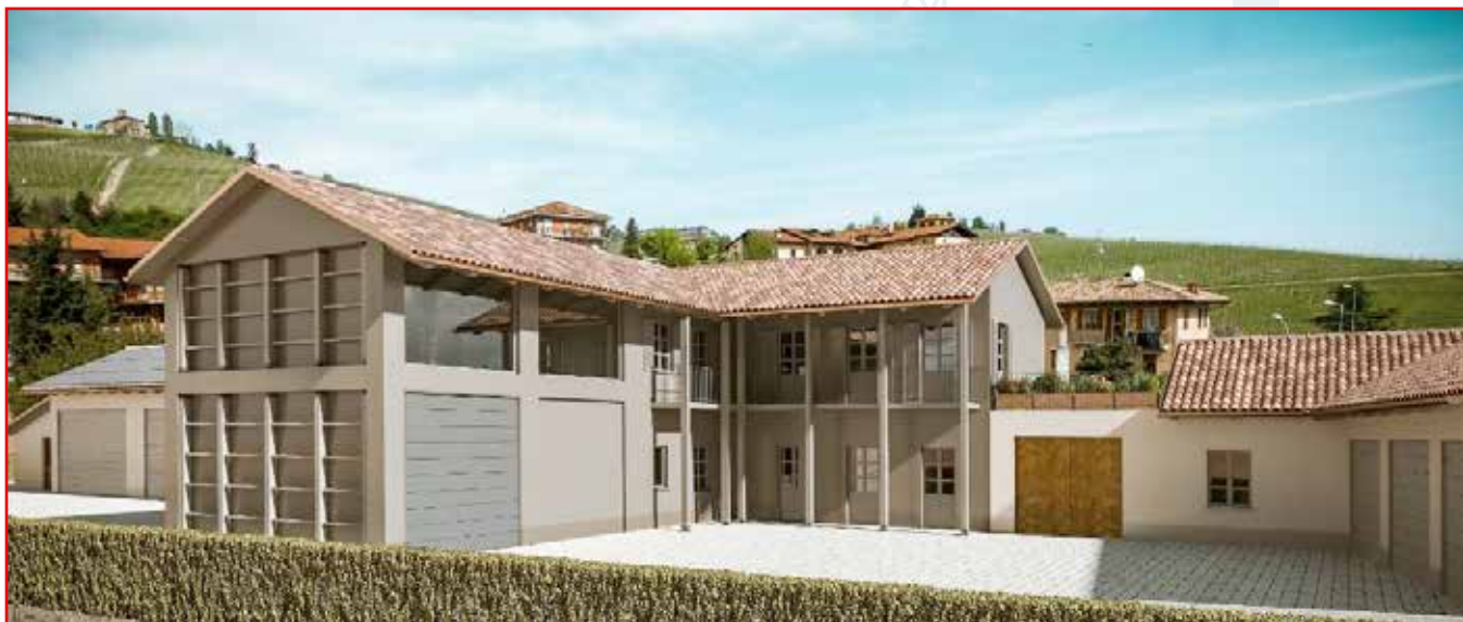
Cantina Mascarello Bartolo - Barolo (CN): demolizione e ricostruzione di fabbricato adibito a cantina
