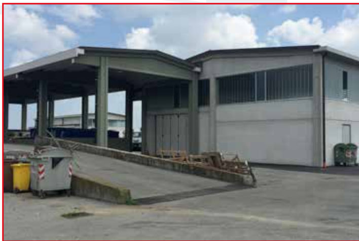
C.S.E.A. - Consorzio Servizi Ecologia ed Ambiente - Cuneo: demolizione e ricostruzione di capannone presso la piattaforma della raccolta differenziata di Revello (CN)
