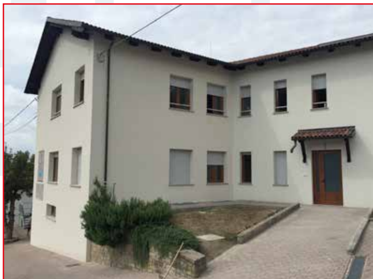
Comune di Prunetto (CN): ristrutturazione ed adeguamento antisismico scuola primaria comunale
